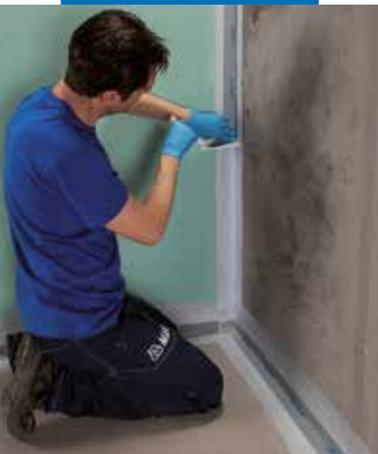
Applicazione di Mapeband PE 120 mediante Mapegum WPS
