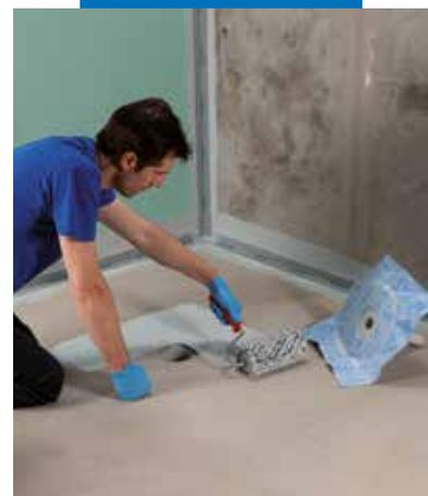
Applicazione di **Drain Vertical** mediante **Mapegum WPS**
