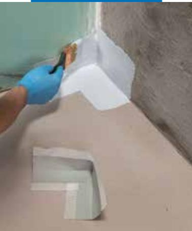
Applicazione angolo 90° di Mapeband PE 120 mediante Mapegum WPS
